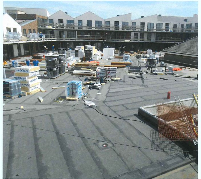
Foto 8: De opslag van bouwmaterialen is onvermijdelijk.
