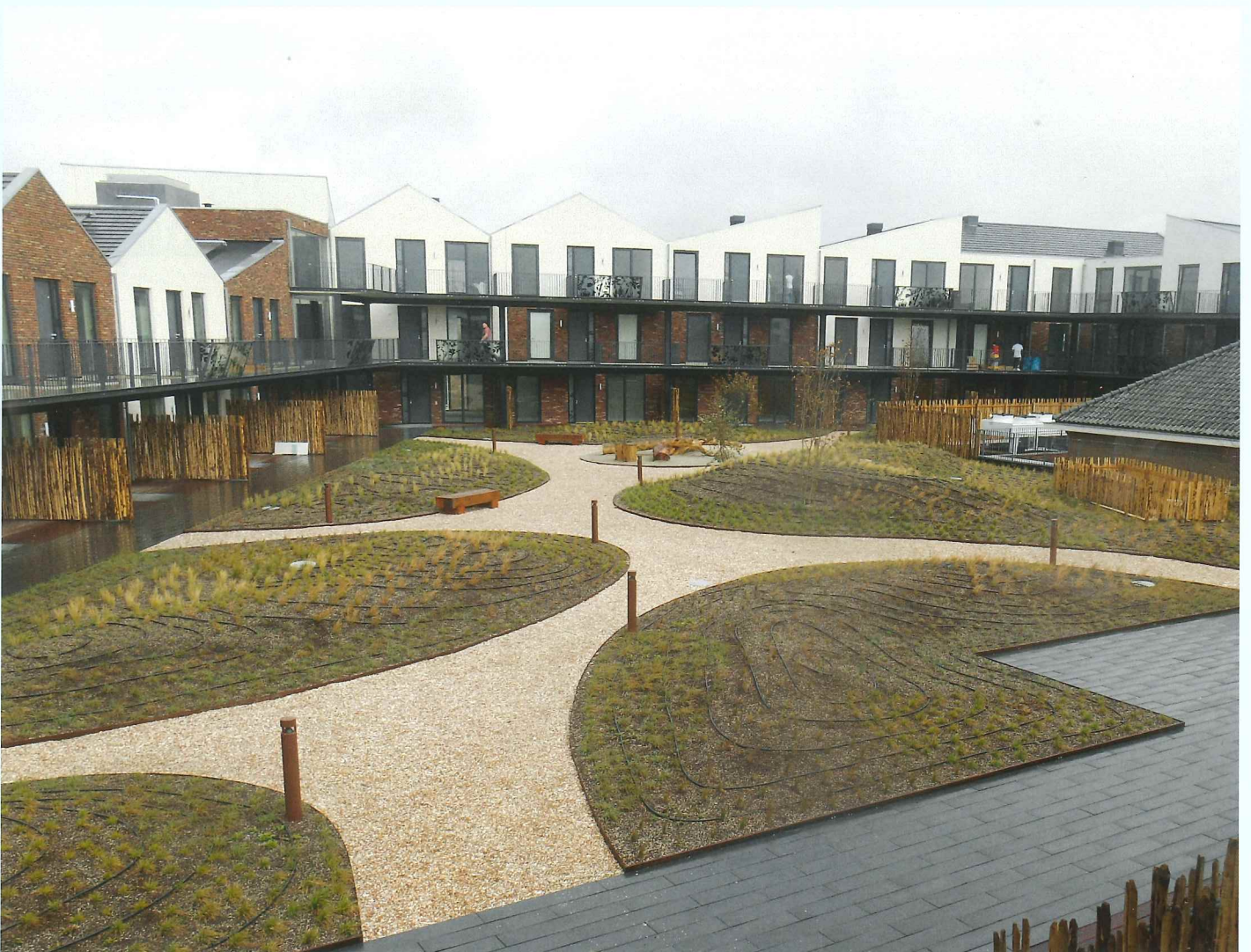
Foto 9: Eindresultaat na aanbrengen daktuin.
