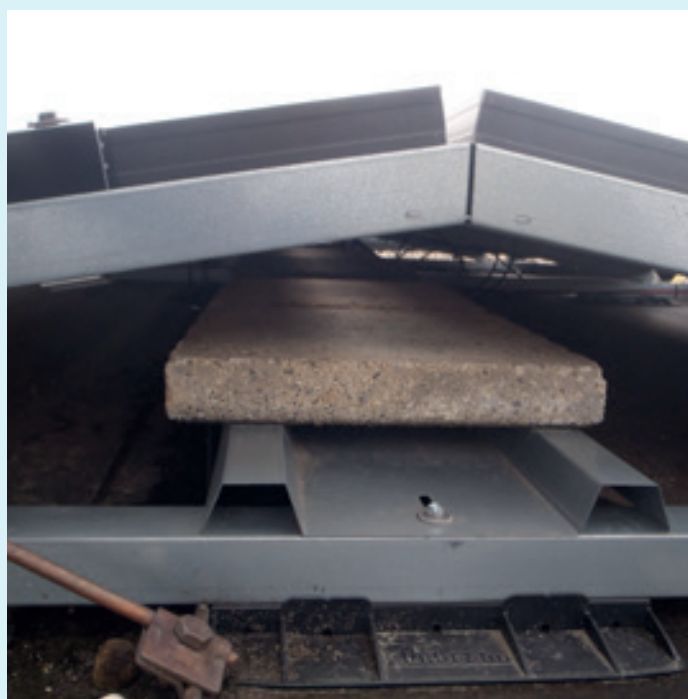
Foto 1 en 2: De ballastlaag is verwijderd om de zonnepanelen te kunnen plaatsen.
